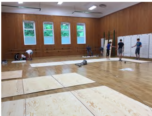
Auslegen und reinigen der 24 Platten
